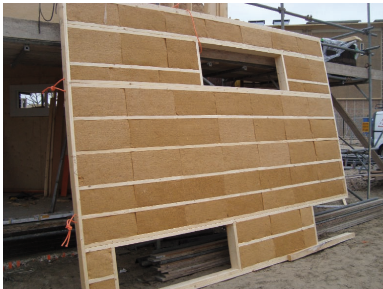
Houtskeletframe met houtvezelplaten.
