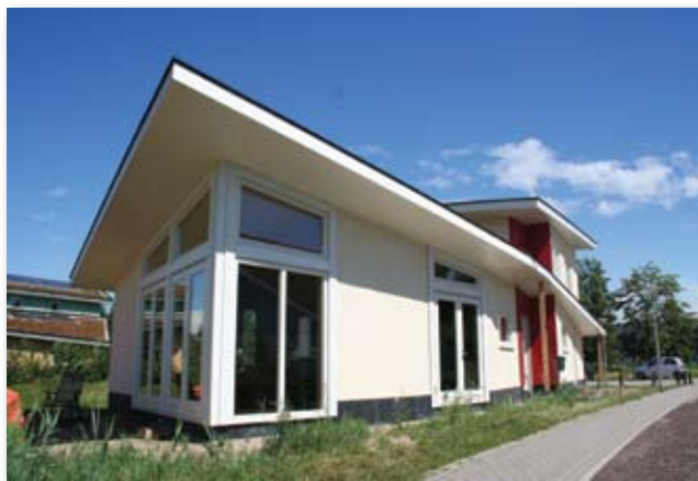
Ecologisch woonhuis Almere: Dakoverstekken aan de zuidkant zorgen ervoor dat de zomerzon niet binnen schijnt en de winterzon juist wel: passieve zonne-energie!
