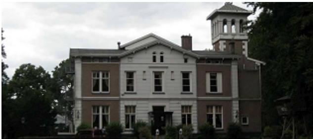
Entreezijde kozijnen oud en nieuw
