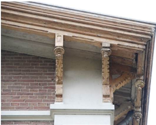
Openingen voor de vleermuizen
