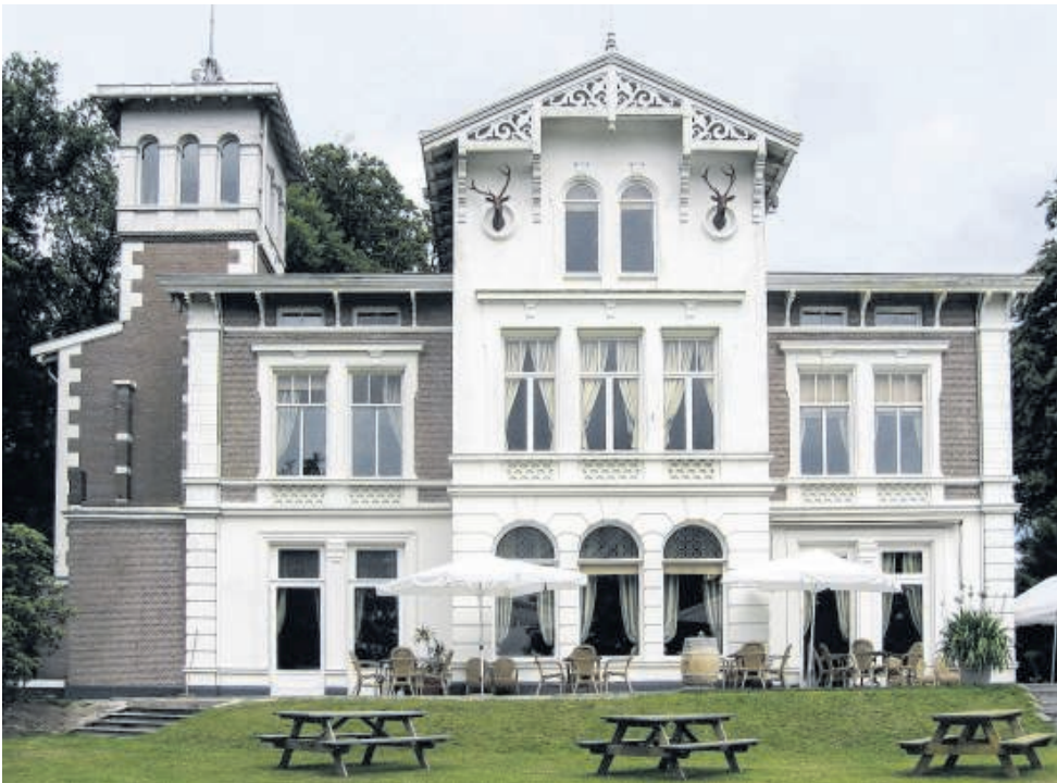
Jachthuis Beukenrode in Doorn. Bij de restauratie geldt: behouden wat er nog is, terugbrengen wat is verdwenen en herstellen wat kapot is.
