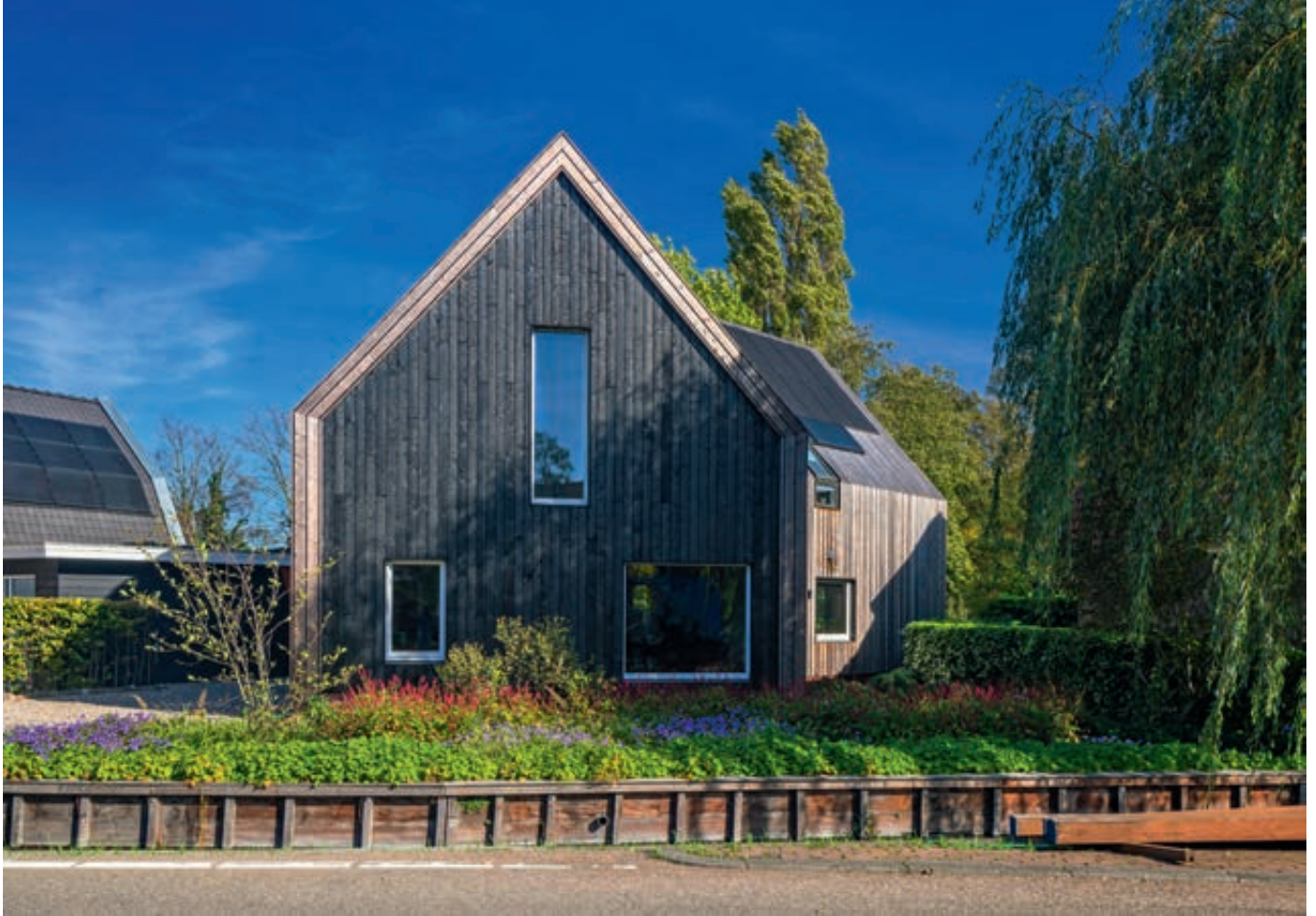
De voorgevel, bekleed met gebrand douglas (Naoshima), is met drie ramen veel meer gesloten.
