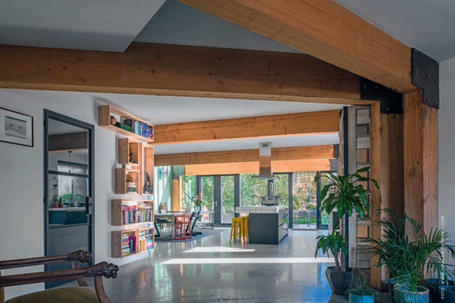
Ook de draagconstructie, bestaande uit vijf spanten van massief douglas, draait naadloos mee met het knikpatroon.
