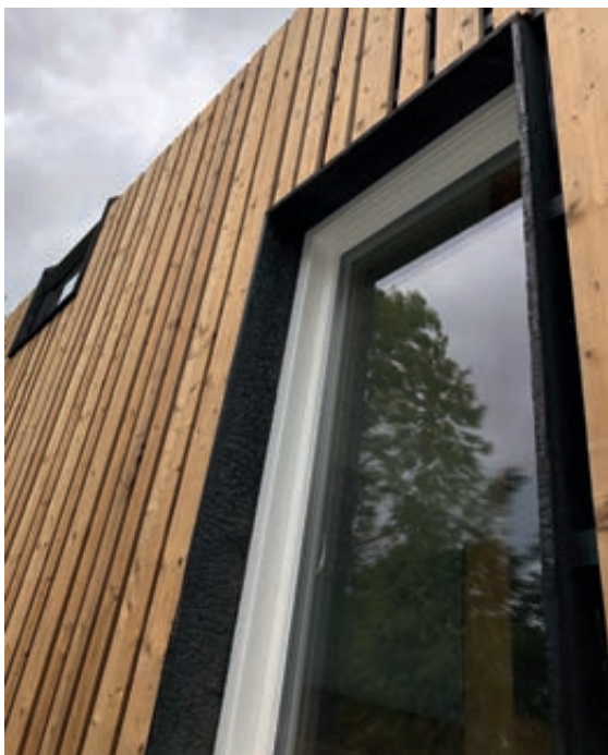
Behalve de voorgevel zijn ook de dagkanten van de kozijnen bekleed met Naoshima, zwart gebrand douglas.
